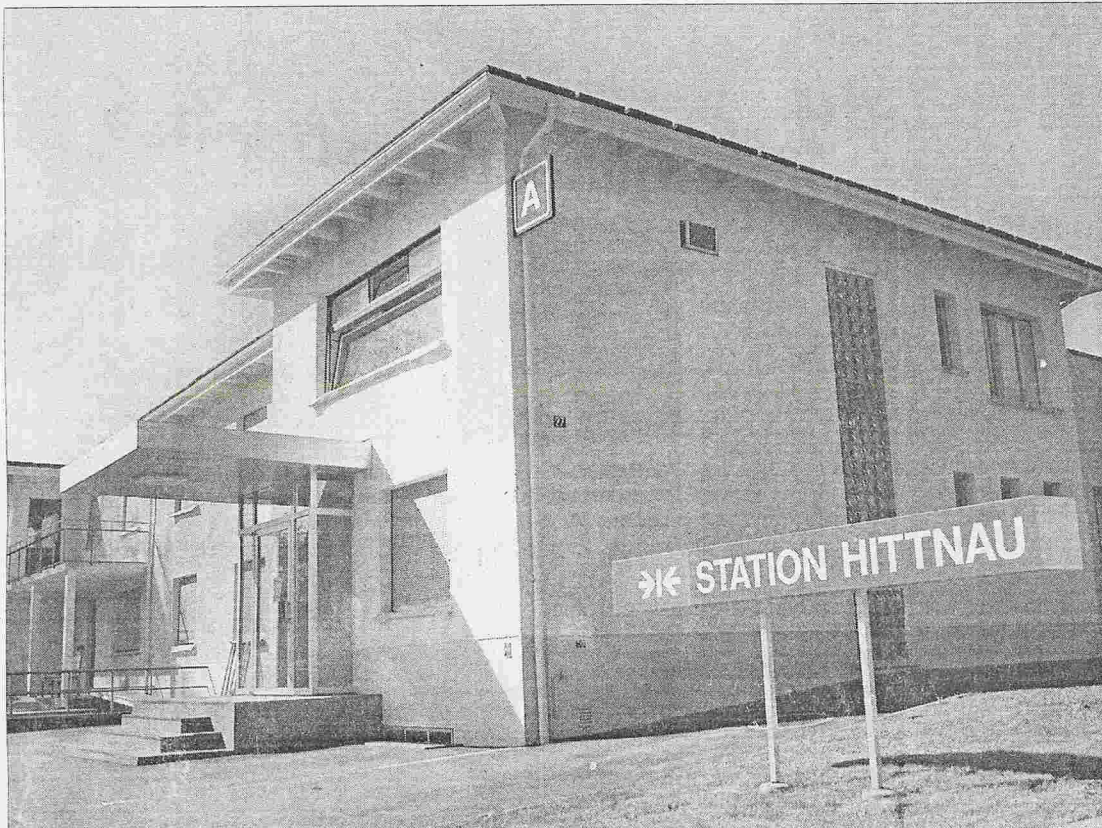
Die neue Anschrift der Gebäude – allfällige Ähnlichkeiten mit der Bahn sind durchaus nicht zufällig. (anf)
