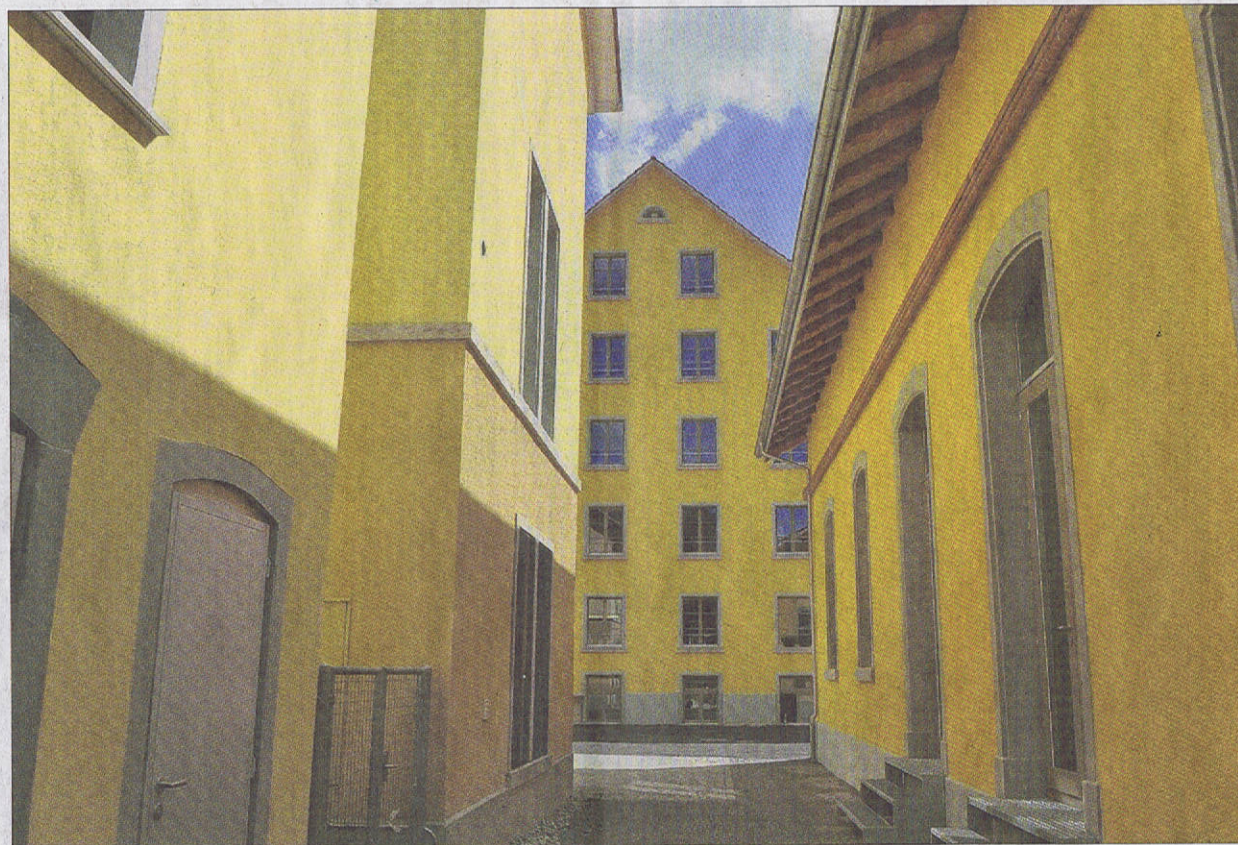
Ein grosser Teil der Altbauten im Spinnereiareal sind inzwischen denkmalpflegekonform renoviert. (dih)
